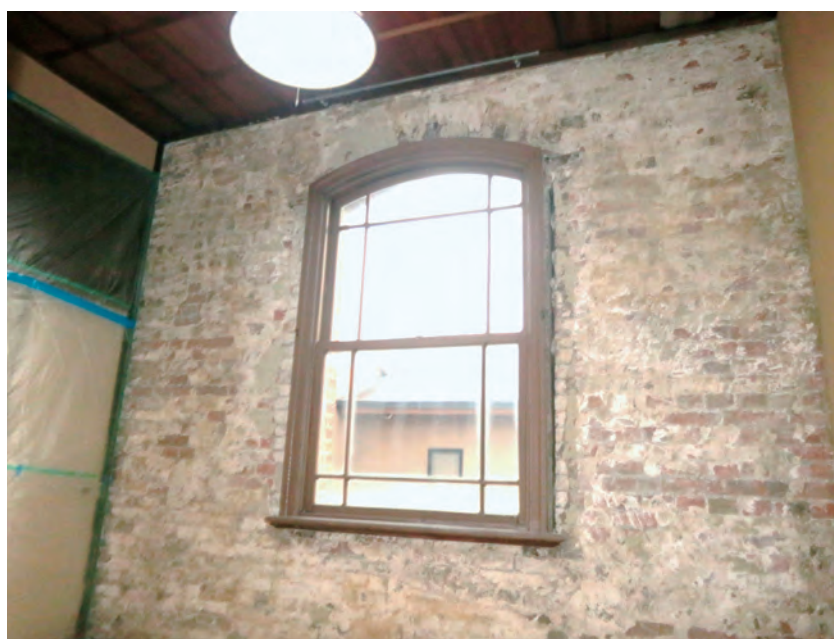
図-1 修理前 既存の聚楽壁土等(荒壁下地)をすべて取り除き、下地処理工程前写真です。
