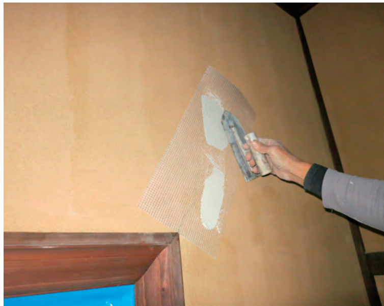
図-2 下地処理作業
