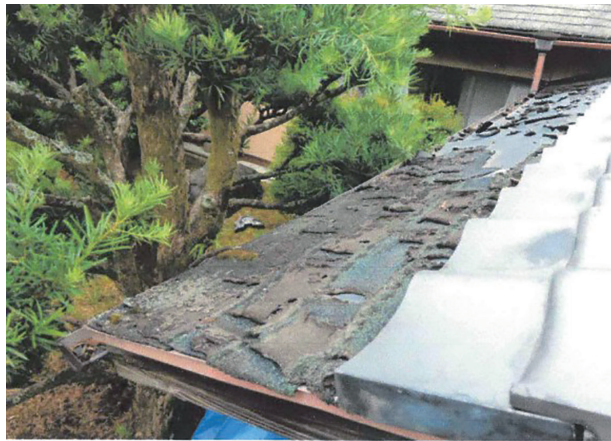
図 1 奥和室の屋根軒先の修理前
